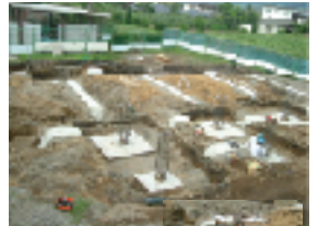
平成18年7月6日 アンカーボルトセット 状況
