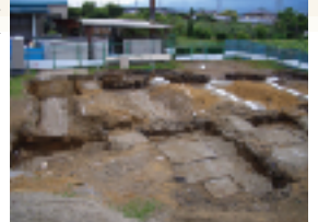
建設場所 平成18年7月1日撮影
