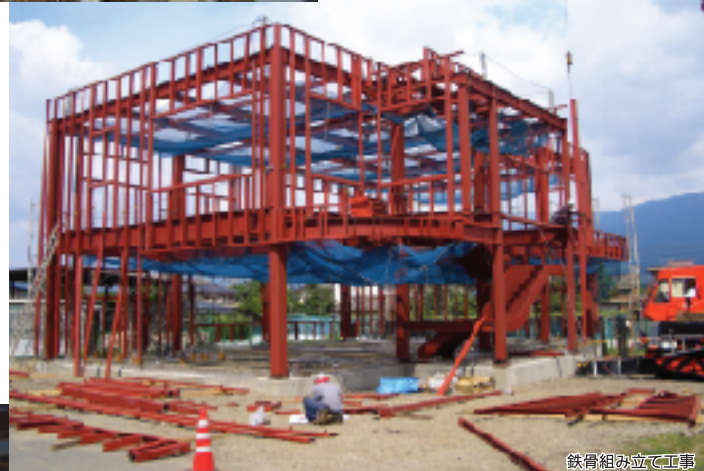
鉄骨組み立て工事
